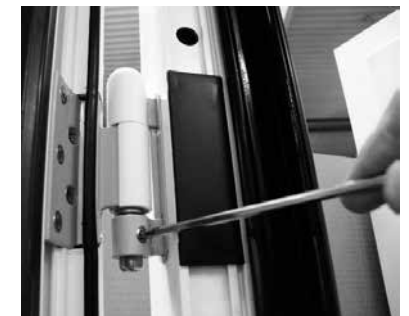
Fixierschraube lösen.
